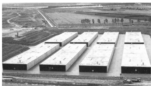
Рис. 2. Тоннельные элементы в сухом доке.
