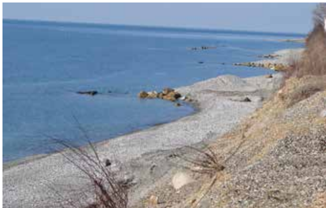
Рис. 3. Вид деформированных каменнонабросных бун [фото автора 07.02.2008].
