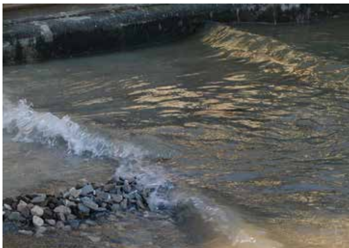
Рис. 5. Взаимодействие волн с каменнонабросной буной [фото автора].
