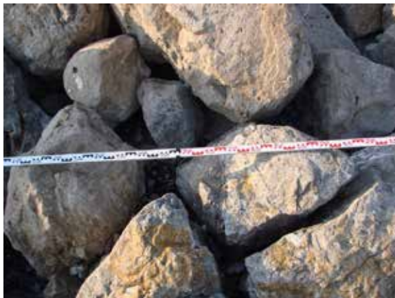
Рис. 4. Оценка крупности камня в каменнонабросных бунях [фото автора 20.07.2007].
