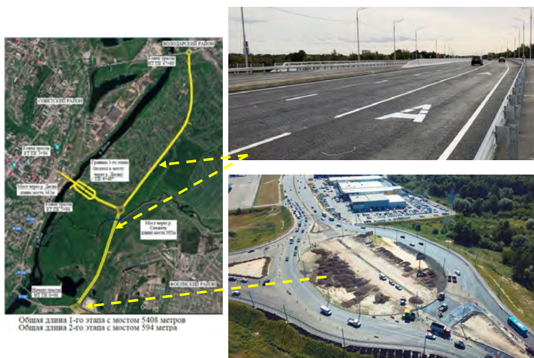
Рис. 4. Построенная защитная дорога – дамба «Брянск 1–Брянск 2» [Составлено авторами по данным статьи «В Брянске началось строительство дороги от вокзала до «Метро». [Электронный ресурс]: https://news.nashbryansk.ru/2019/11/13/routine/nachalos-stroitelstvo-dorogi-bryansk-1—bryansk/ . Доступ 03.12.2021.
