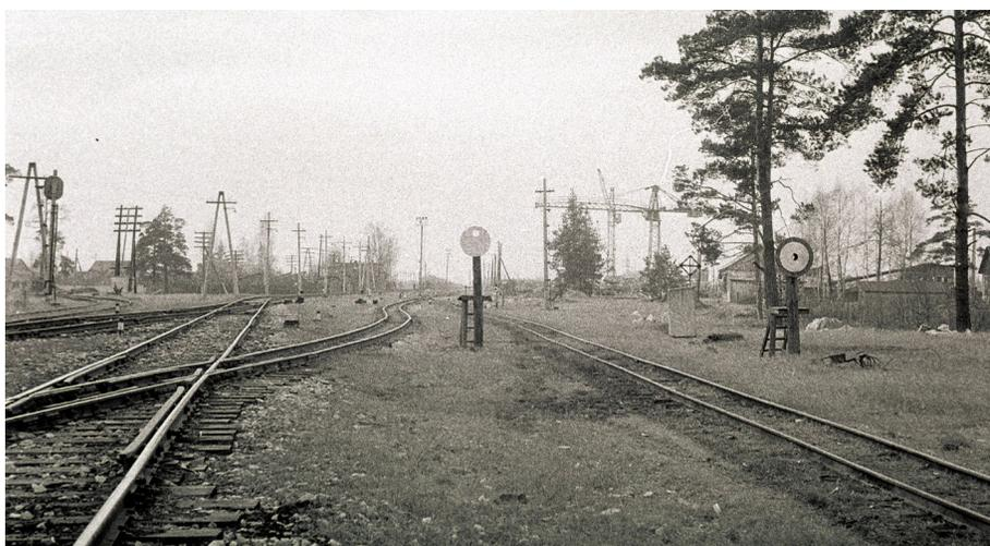
Рис. 13. Горловина станции Пилёво. Справа налево перегоны: Пилёво–Тюково, Пилёво–Спас-Клепки узкой колеи, Пилёво–Сороковой Бор нормальной колеи. Фото В. Миронова, публикуется с его разрешения.
