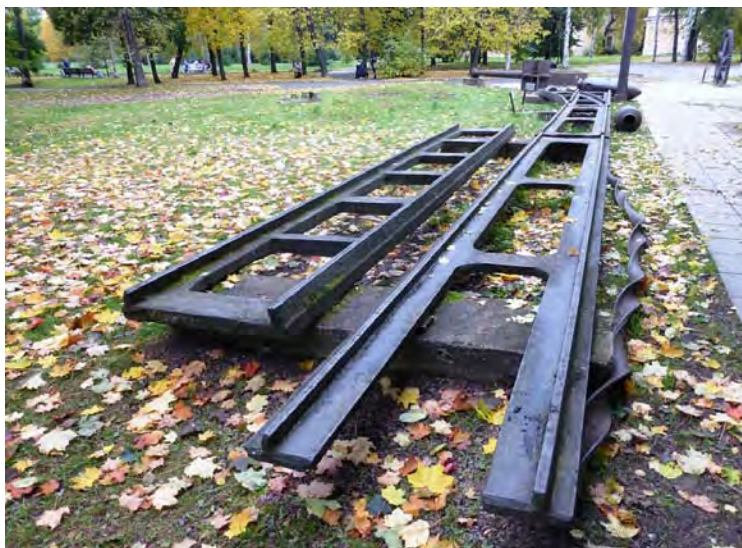
Рис. 1. Конструкция верхнего строения пути «чугунный колёспровод». [Электронный ресурс]: https://umcздт.ru/news/demohtml/80.html . Доступ 11.06.2021.
