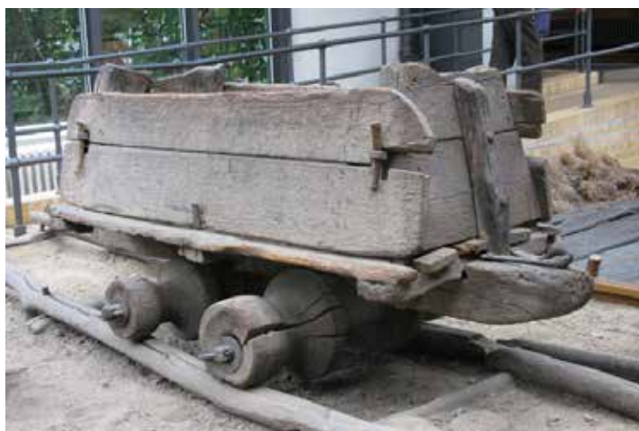
Рис. 8. Деревянная вагонетка на деревянных направляющих (лежнях) с колёсами, имеющими реборды. (История железнодорожного транспорта. [Электронный ресурс]: https://ru.wikipedia.org/wiki/История_железнодорожного_транспорта . Доступ 11.06.2021).
