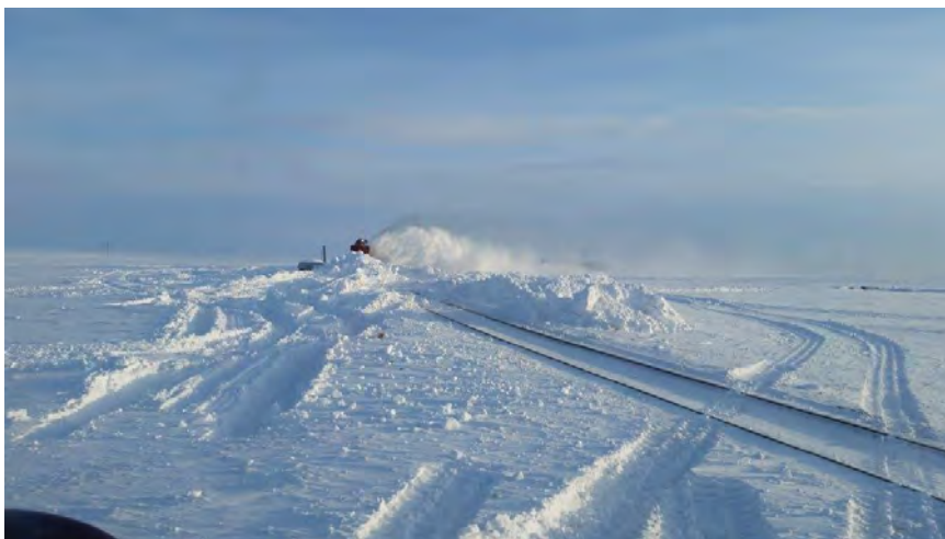
Рис. 12. Разделка снежной выемки с использованием машины ФРЗ (фото автора В. В. Шапран, 2015 год).
