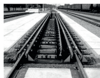
4. Переводное устройство системы SUW 2000 (Польша)
