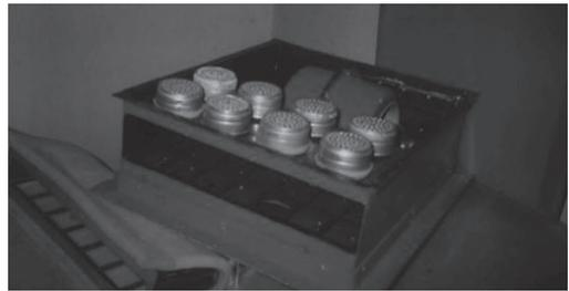
**Рис. 8. ФВУ (верхняя крышка и фильтр сняты).**
