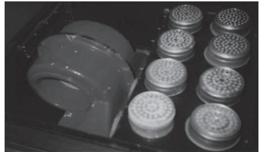
**Рис. 9. Вентилятор и блок фильтров ФВУ.**
