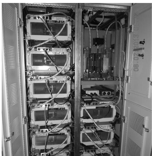
**Рис. 3. Накопительные модули внутри шкафа.**
