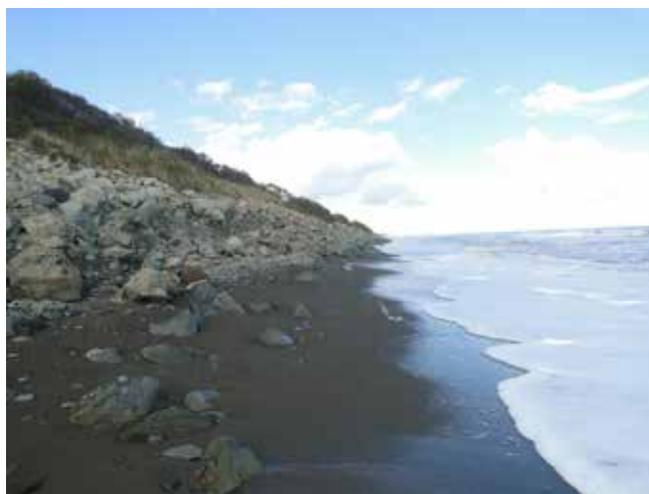
Рис. 3. Подмыв основания откоса земляного полотна на 273-м км участка Корсаков – Ноглики. 2020 год [фото авторов].
