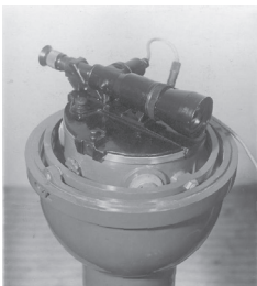
Рис. 2. Морской ИК-пеленгатор «Омега-ВЭИ» на репитере gyroкомпы. 1942 г.
