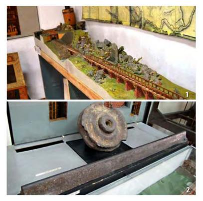
Рис. 7. Чугунная дорога с конной тягой в Змеиногорске: 1 – макет «чугунки»; 2 – фрагмент чугунного рельса и колеса вагонетки. Змеиногорская «Чугунка» – прародительница российских железных дорог. [Электронный ресурс]: https://chuguntv.ru/zmeinogorskaya-chugunka-prarodite/. Доступ 11.06.2021.
