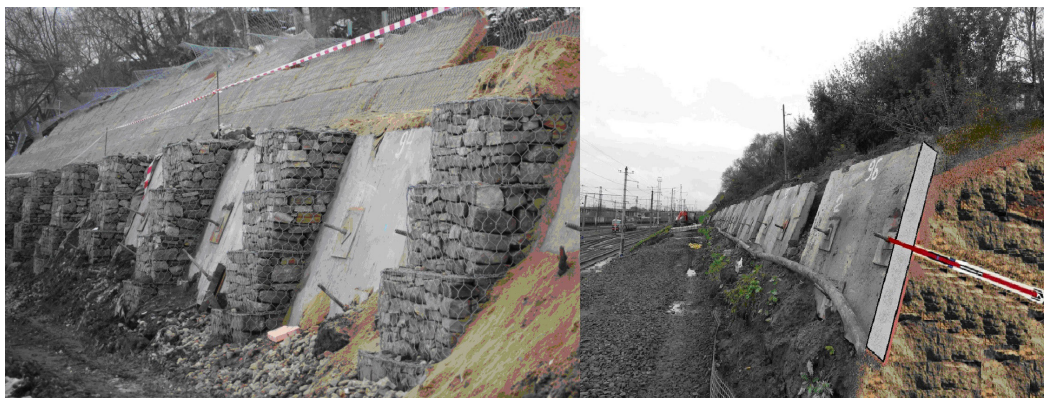
Рис. 3. Общий вид объекта.
