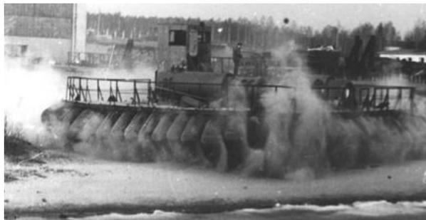
му на воздушной подушке. Такая платформа может разрушать довольно толстый лед при движении с относительно малой скоростью. Опытный образец (рис. 3) был испытан на Горьковском водохранилище и показал свою эффективность [1].
