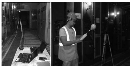
Рис. 1. Измерения ЭМП в тяговой подстанции.
