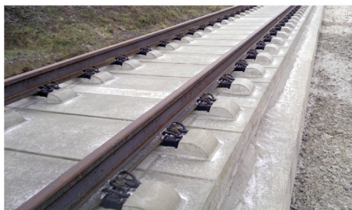
б) на сплошном подрельсовом основании неразрезного типа Bögl
