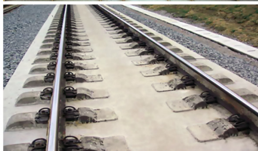
а) двухсекционная монолитная RHEDA 2000
