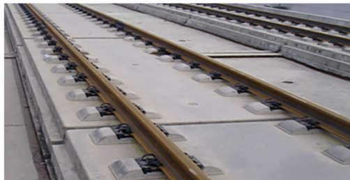
в) на сплошном подрельсовом основании блочного типа CRTS III
