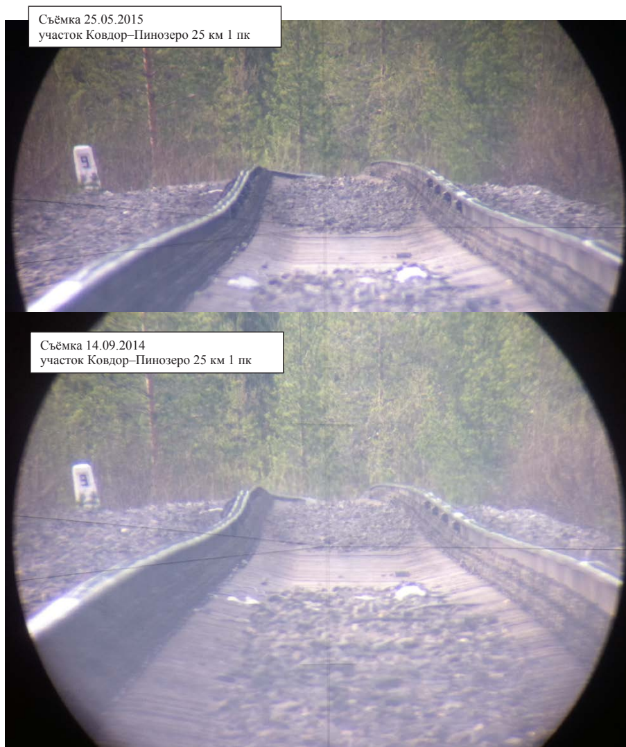
Рис. 6. Относительные просадки пути на 25-м км участка Ковдор–Пиноезеро.
