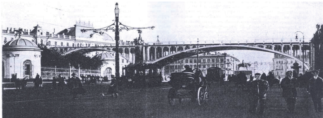
Путепровод на Знаменской площади против Невского проспекта.
