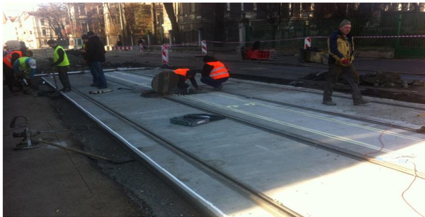
Рис. 10. Установка опалубки из пенополистирола перед выливанием бетонной смеси.
