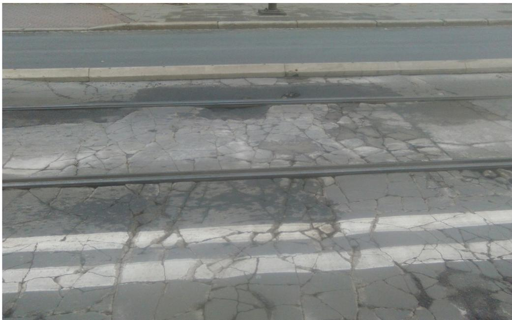
*Рис. 1. Существенные трещины и сколы в покрытии.*
