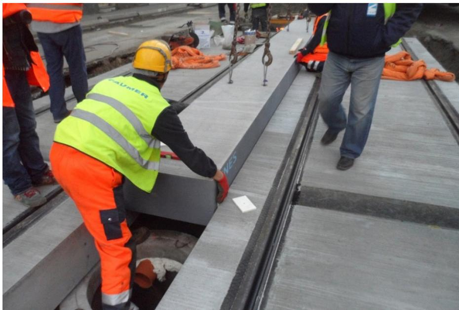
Рис. 9. Укладка плиты междупутья в районе канализационного люка.
