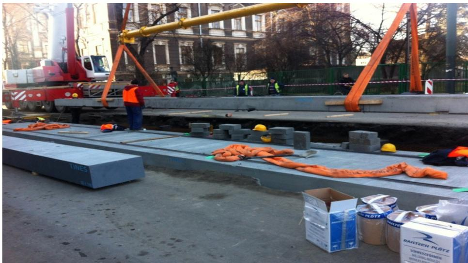
Рис. 7. Укладка плиты TINES LC–L XL.
