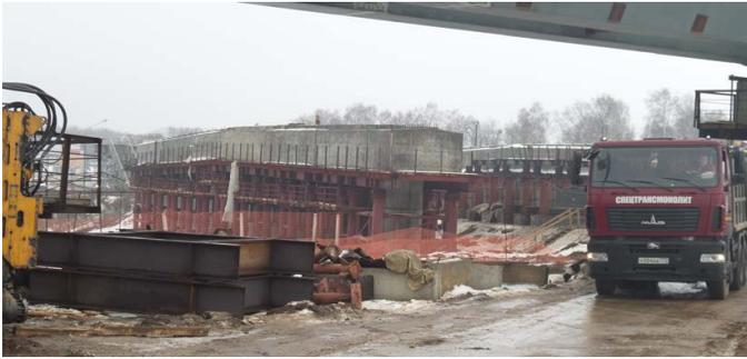
*Рис. 5. Опоры моста и пролётное строение.*
