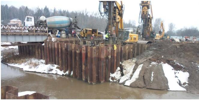
*Рис. 4. Строительство береговых укреплений.*
